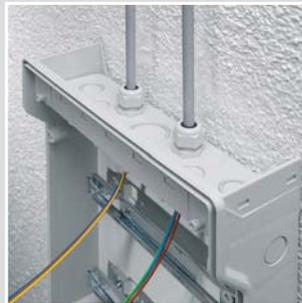
Ввод кабеля или трубопровода посредством импрегнированных метрических отверстий.
